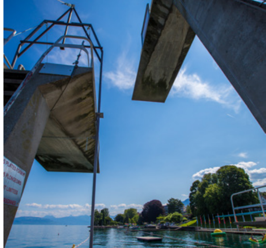
Plongoirs de la piscine, par l'architecte Maurice Novarina, 1968, Évian-les-Bains © Éviau Tourisme & congrès (Benjamin Delerue)
