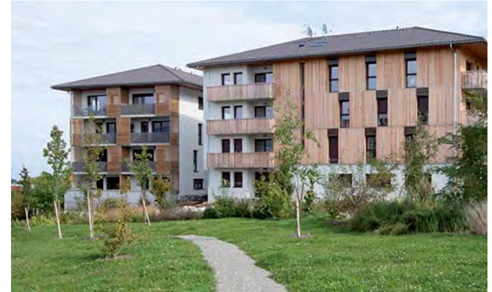
Viry (74), logement collectif. Filtre végétal qui tient à distance la rue et le jardin collectif et permet l'intimité des logements et des rez-de-jardin. Plusieurs strates (vivaces, arbustes et arbres) composent la limite traitée en épaisseur, apportant une souplesse.
