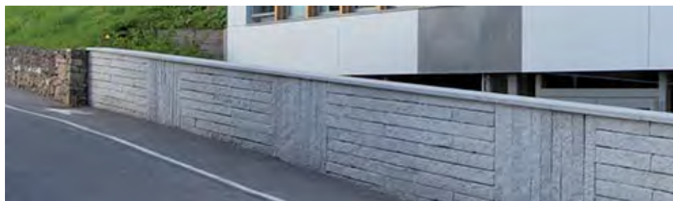
Lucinges (74), Muret bas contemporain en continuité (implantation et hauteur) du muret en pierre existant
