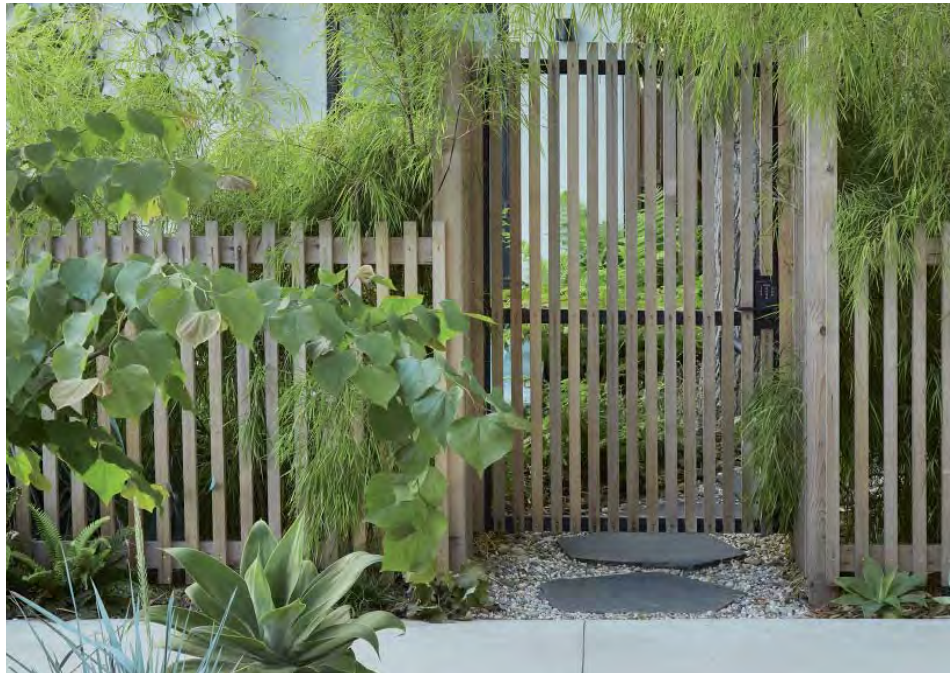
Clôture en ganivelle associé à une haie basse taillée / clôture à barreaudage bois
