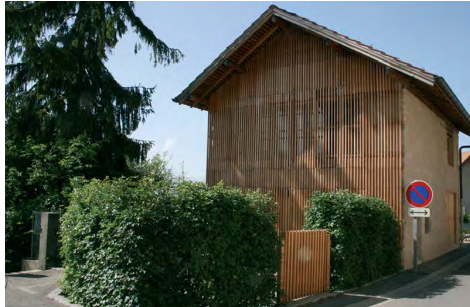
Collonges sous Salève (74), Traitement du portillon en unité avec le traitement de la façade
