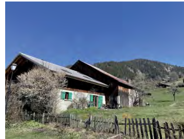
Gauche : Abondance, claustra bois marquant l'espace du jardin Droite : Vacheresse - le Villard, claustra bois marquant la limite de l'espace privé
