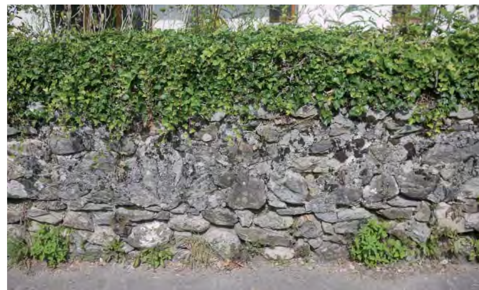
Lugrin - muret en pierre en coeur de village
