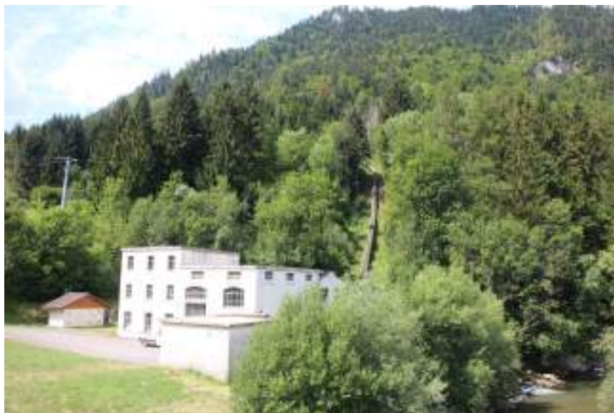
Fig. 16- Centrale hydroélectrique de Bonnevaux.
