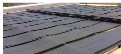
Figure 62: les capteurs non vitrés (ou "moquette" ou "atmosphériques")
