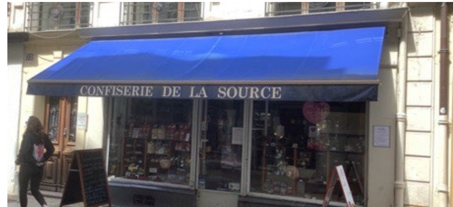
Enseigne parallèle au mur sur le lambrequin d'un store-banne, Évian-les-Bains
