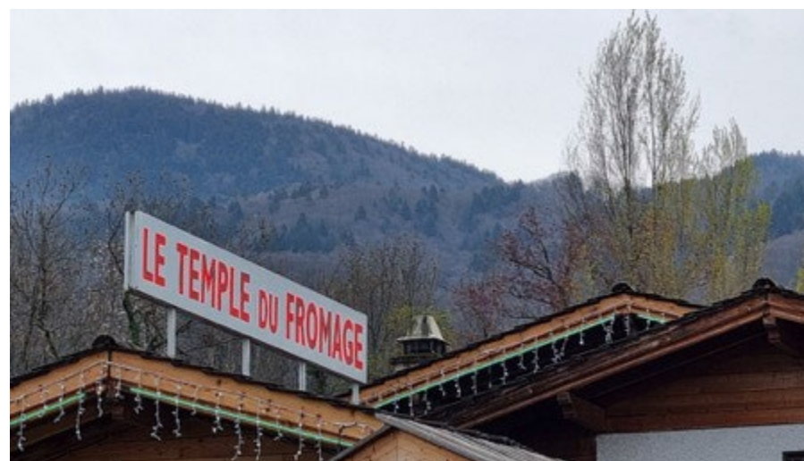
Enseigne sur toiture avec un panneau de fond, Lugrin
