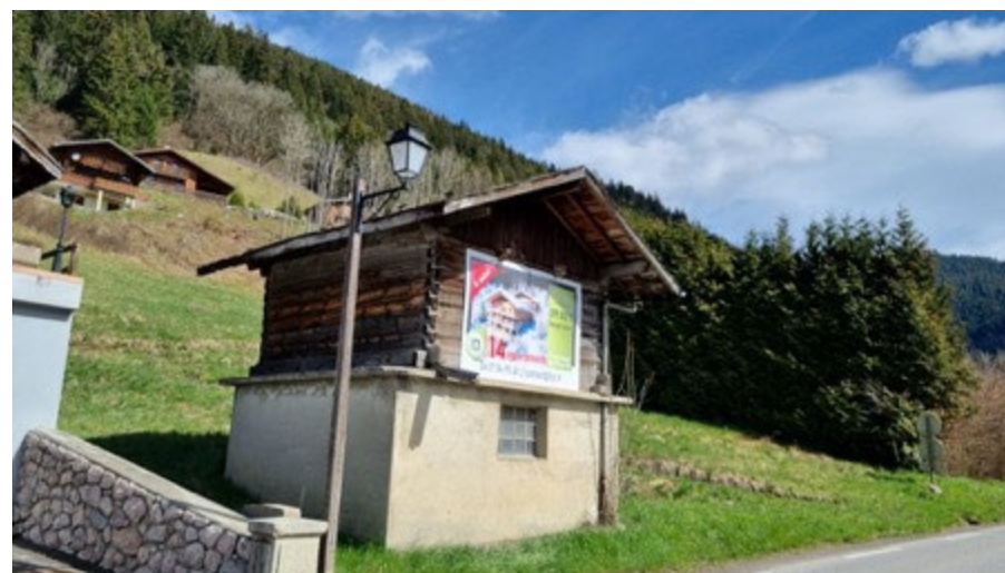
Enseigne temporaire en façade liée à l'immobilier, la Chapelle d'Abondance
