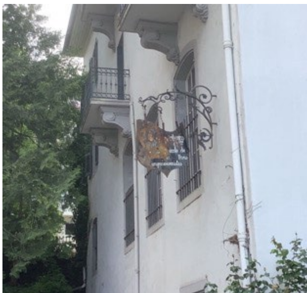
Enseigne perpendiculaire au mur en fer forgé, Évian-les-Bains
