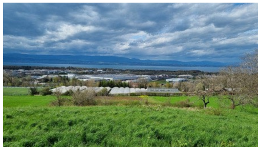
L'usine Évian vue depuis les hauteurs de Publier, Publier
