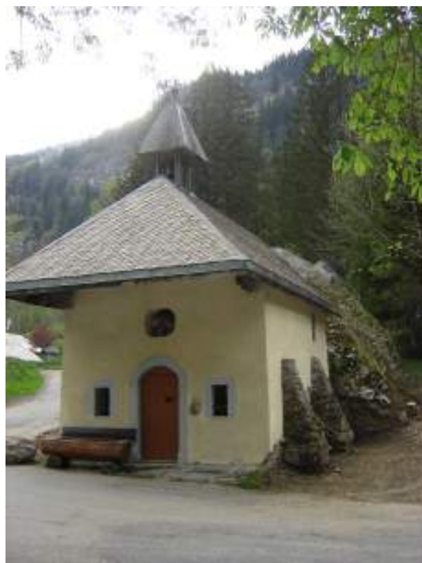
Fig. 10 - Chapelle à Très-les-Pierres.
