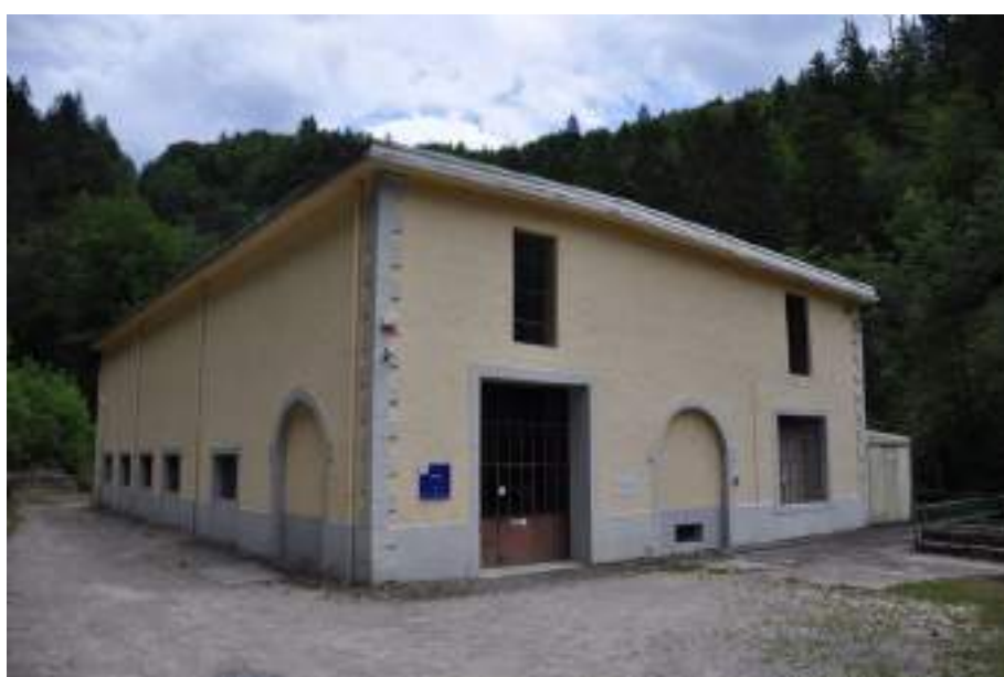
Fig. 22 - Centrale hydroélectrique (Photo : Région Rhône-Alpes, Inventaire général du patrimoine culturel).
