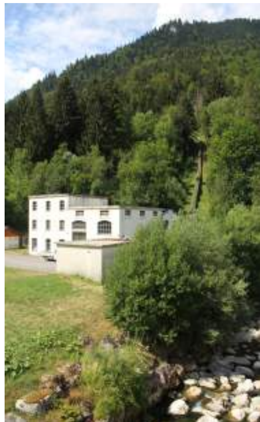
Fig. 15 - Centrale hydroélectrique au pont de l'Eau noire.
