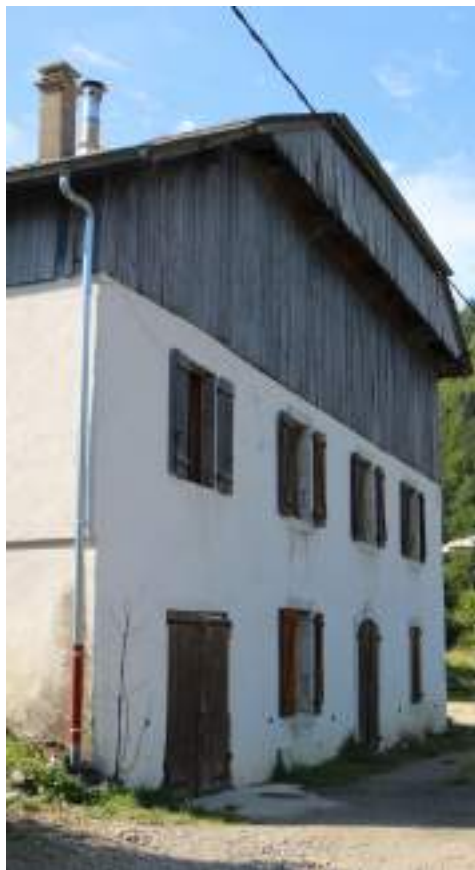
Fig. 15 - Ancienne ferme à Vers l'Usine.
